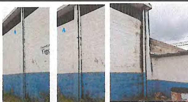
Foto: 6 Sustitución de bajas de agua pluviales
