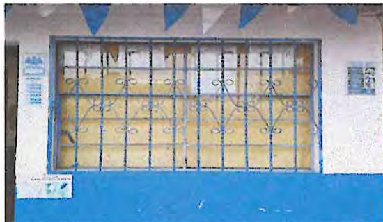
Foto: 4 Mantenimiento de balcones.
