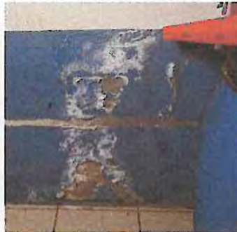
Foto: 9 Reparación de repello y cernido de paredes en aula
