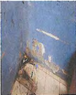
Foto: 9 Reparación de repello y cernido de paredes en aula
