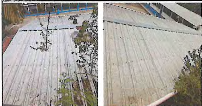
Foto: 1 Sustitución de lámina troquelada en 2 aulas.
