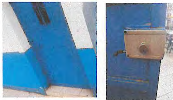
Foto: 2 Mantenimiento a puertas de metal y cambio de chapa en aulas
