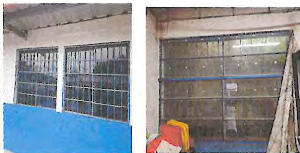
Foto: 3 Sustitución de ventanas de vidrio por pvc en aulas
