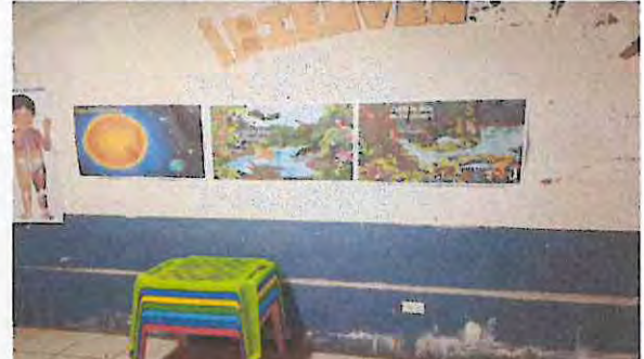
Foto: 10: Reparación de repello y cernido en pared de aula
